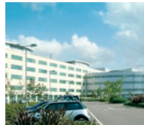
Insgesamt wurden 36 Dyson Airblade Händetrockner im The Great Western Hospital installiert, weitere sind geplant.
